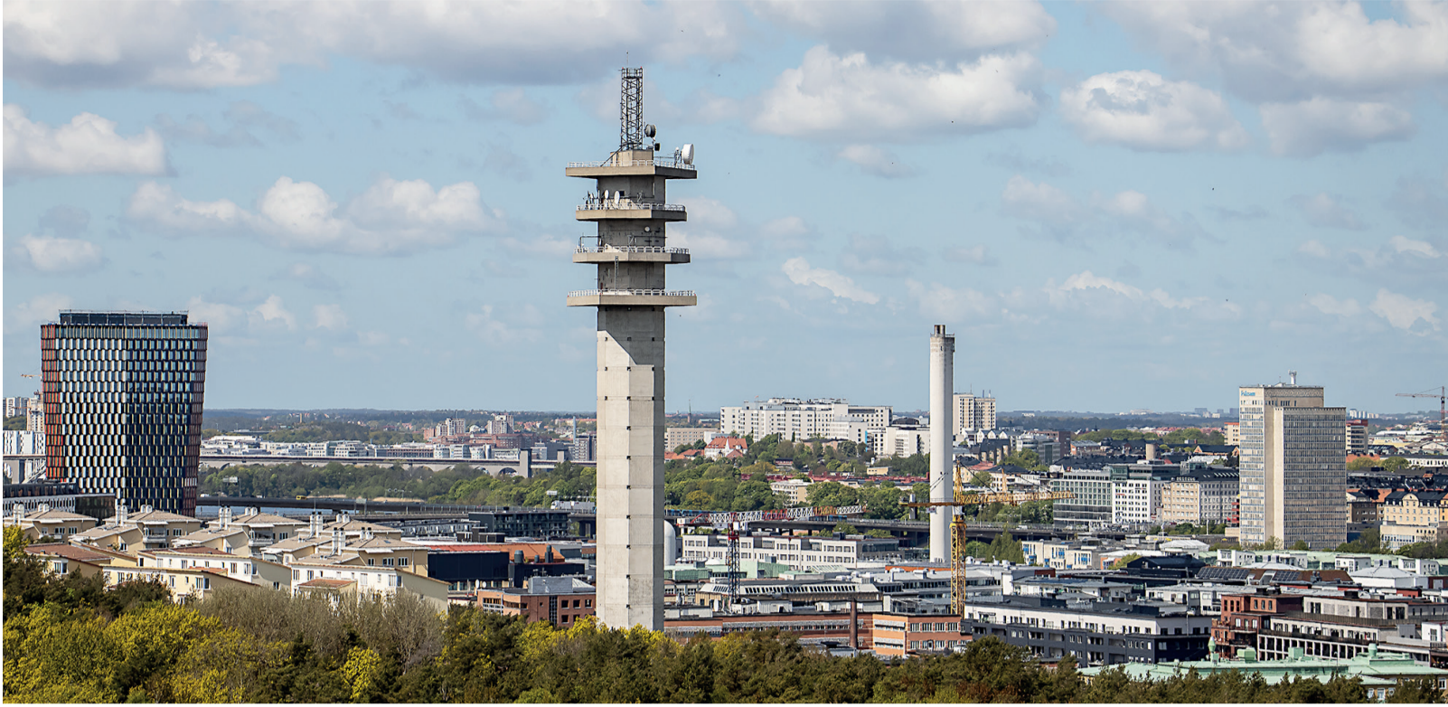
Hammarbytornet reser sig 90 meter över marken och under ligger bergsrum i tre våningar. Foto: Pelle Hultman
